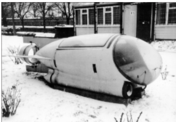
Niewielki pojazd podwodny typu mokrego, dla płetwonurka (w eksploatacji jeszcze w 1999 r.)
