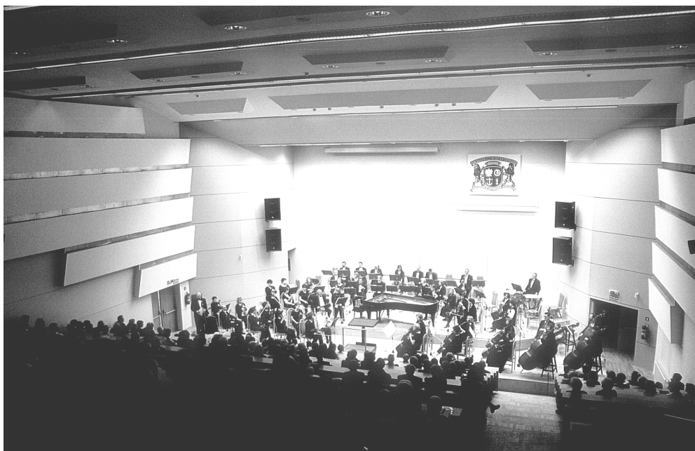
Rys. 2.26. a) Profilowanie ścian, kierujące dźwięk odbity ku widowni i usuwające akustycznie niekorzystną równoległość dużych, płaskich powierzchni, które stanowią ściany boczne. b) Przykładowe rozwiązanie: Auditorium Novum Politechniki Gdańskiej. Kubatura - 3880 \text{ m}^3 , widownia - 474 miejsca. Architektura: Adam Iwanaszko
