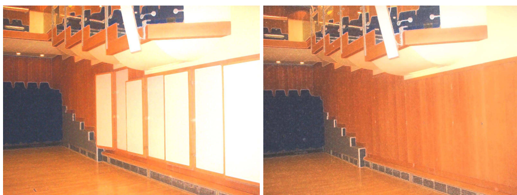
Rys. 2.92. Elementy ścienne służące do regulacji czasu pogłosu w Studiu Muzycznym w Regionalnej Rozgłośni Polskiego Radia w Katowicach. Kubatura: 975 \text{ m}^3 , widownia: 180 miejsc, czas pogłosu przy elementach ściennych otwartych i zamkniętych: odpowiednio 1,1 i 1,4 s ( f = 1 \text{ kHz} ).
