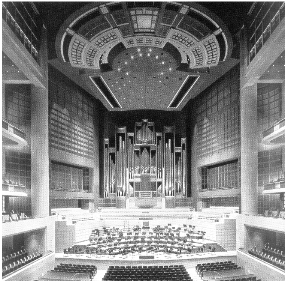
Rys. 2.99. Komora pogłosowa pozwalająca zwiększyć czas pogłosu sali w zakresie małych częstotliwości
