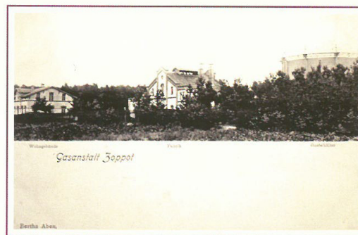
Druga gazownia w Sopocie. Widok od strony wschodniej z początku XX wieku przed rozbudową w roku 1906. Od lewej budynek biurowy, budynek produkcyjny o nieco innych elementach wykończenia głównego szczytu kryjącego piecownię, zbiornik V = 800 \text{ m}^3 . (ze zbiorów Biblioteki Gdańskiej PAN)
