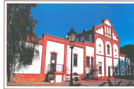
Widok współczesny zrekonstruowanego i zaadaptowanego do nowych celów budynku poprodukcyjnego dawnej drugiej gazowni w Sopocie. W jego przziemiu mieści się zaplecze tutejszej Rozdzielni Gazu. (ze zbiorów PZG w Gdańsku)
