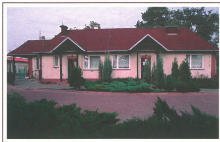
Widok współczesny budynku biurowego zaplecza Rozdzielni Gazu w Malborku (ze zbiorów PZG w Gdańsku)
